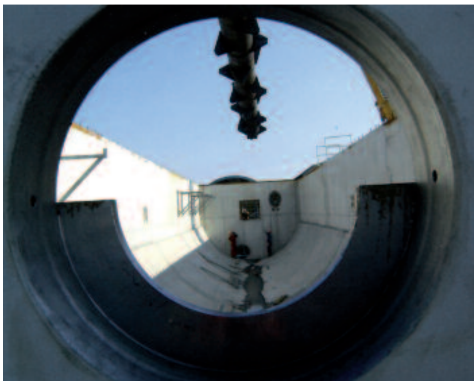
Bij de VAR in aanbouwzijnde composteerinstallatie.
